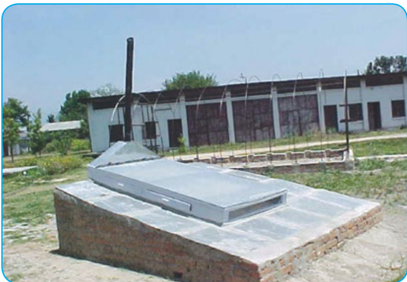
सरल थ्याचो सोलार ड्रायर (Simple Thyapcho Solar Dryer)
